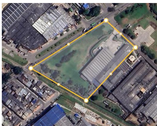
Figura 4. Condiciones previas del predio
